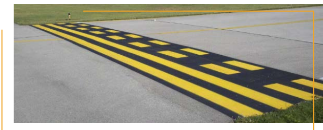
HOLDING POSITION: POSIZIONE DI ATTESA INGRESSO PISTA
