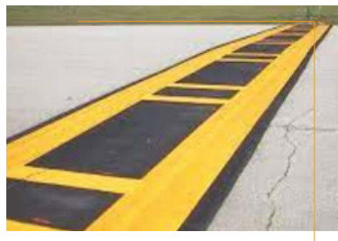
HOLDING POSITION POSTA A PROTEZIONE DELL'ILS
